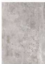
Hormigón fratasado. aparcamiento exterior
